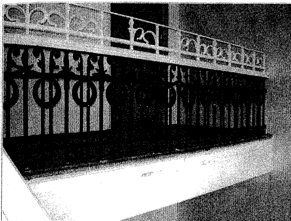
25. «Здание частной гимназии Н.П. Степанова, 1915 г.». Парадная лестница. Ограждение лестничной площадки.
